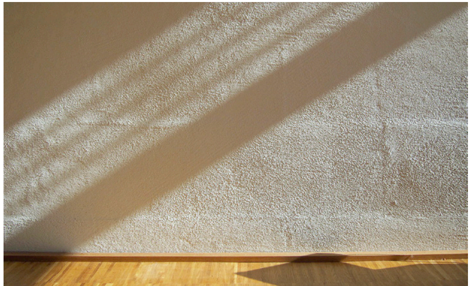
In einer der elf Wohnungen wurde der gleiche Typ Steine wie für die Fassade verwendet und die Oberflächen mit Kalk geschlämmt.
