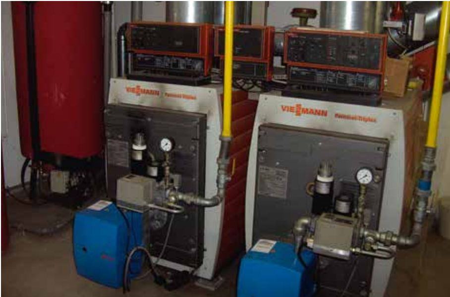
Die Zwilling-Heizungsanlage mit einer Leistung von je 45 bis 111 Kilowatt für alle Gebäude wurde ausgebaut.
