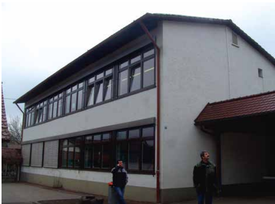
Südansicht der Aula mit Isolierverglasung in Alurahmen von 1970
