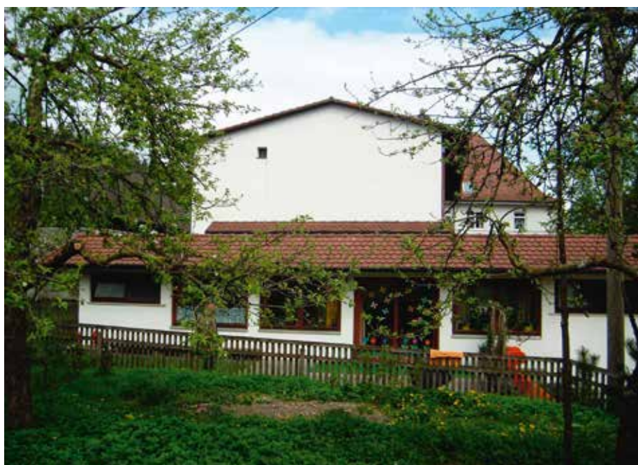
Wie alle Zubauten wurde auch der Kindergarten durch Leitungen versorgt, die in einem unterirdischen Kriechkeller geführt wurden.
