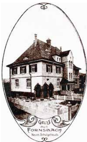
Die Montessorischule wurde 1912 erbaut und steht heute unter Denkmalschutz.
