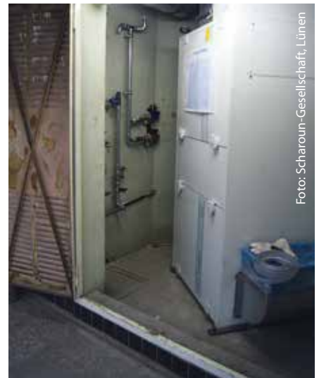
Ein neues Kompaktlüftungsgerät im angrenzenden Technikraum sorgt für frische Luft und ertüchtigt das bauzeitliche System.
