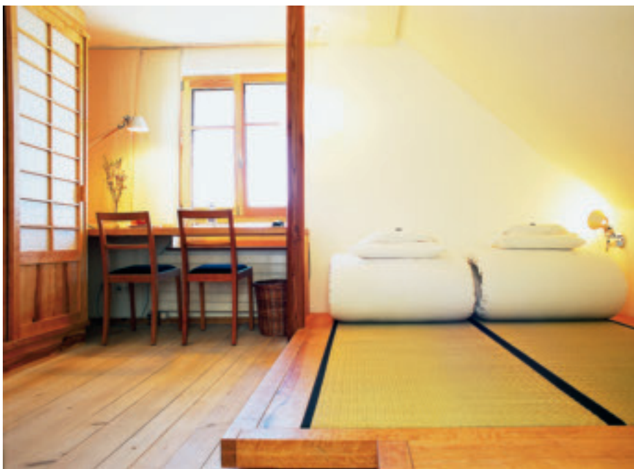
Zum Berühren schön: Unter dem Dach wurden die neuen Fenster nur aussen lackiert, innen hingegen geölt.
