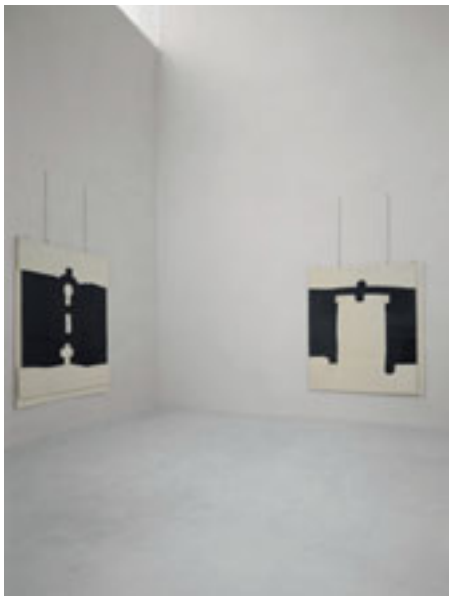
Über 14 Meter hohe, ansatzfreie Putzflächen verlangten präzises und aufeinander abgestimmtes Arbeiten von bis zu sieben Putzern.
