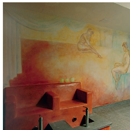
6 Auch organische Untergründe im Innenraum, wie in diesem Wellnessbereich, lassen sich mit einer Sol-Silikatfarbe sanieren und danach beispielsweise schön lasieren.
