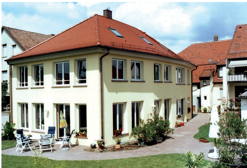
Der Neubau schwingt sich in den Bestand ein. Die lange Ostseite ist leicht gekrümmt und gibt den Weg in den Garten frei
