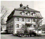
Das sanierte Herrenhaus in Haussach wurde 1760 erbaut; 1980 stand es vor dem Abriss. Heute wird es als Heimatmuseum, Schule und Vereinsheim genutzt.
