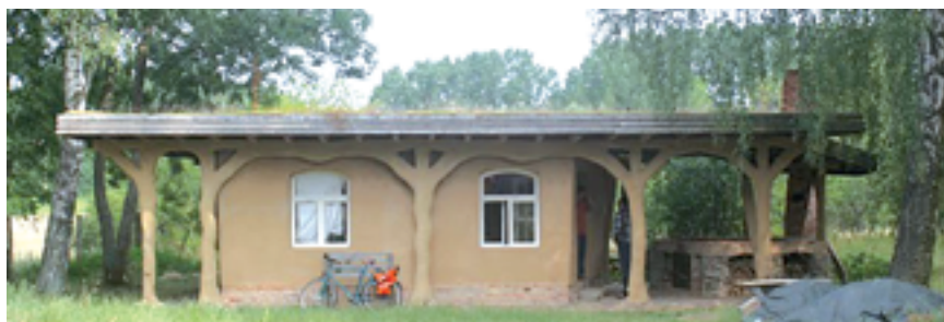
Das Seminarhaus des FAL wurde aus Strohballen gebaut und innen wie außen mit Lehm verputzt
