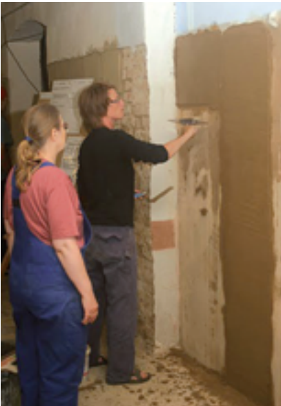
Erstellung eines Musters auf Basis eines erdigen Lehmfeinputzes, rechts im Bild das dunkle Ursprungsmaterial.
