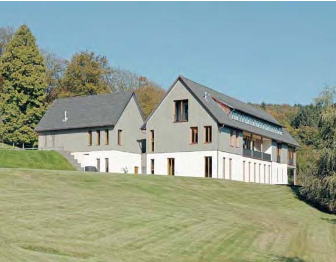
Abb. 1 Das idyllisch gelegene Ecolut Center erinnert formal und durch die Auswahl der regionalen Baustoffe an ein Gehöft.
