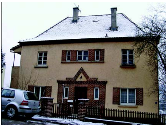
Vor der Sanierung belebten Fenstersprossen die Fassadenansicht; mit der neuen Dachform und der frischen Farbe sieht der Altbau nach der Sanierung sehr modern aus.
