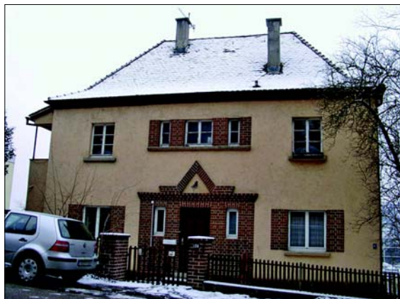
Vor der Sanierung belebten Fenstersprossen die Fassadenansicht; mit der neuen Dachform und der frischen Farbe sieht der Altbau nach der Sanierung sehr modern aus.
