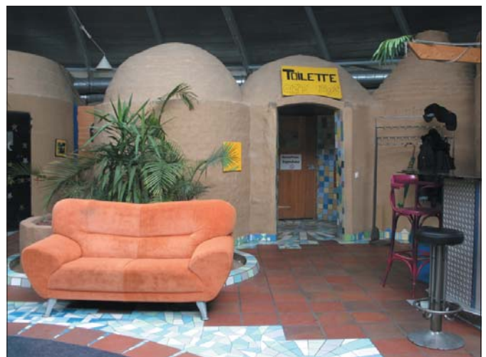
Für freie Formen eignet sich Lehm ganz besonders. Beim Jugendhaus Möglingen wurden die Lehmsteine vor Ort hergestellt, vermauert, ver- putzt und teilweise mit Skulpturen verziert.
