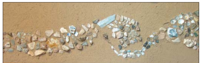
Bei diesem Neubau half die Baufamilie intensiv mit: Die Wand aus Lehm- steinen ist mit Tadelakt verputzt und mit Steinornamenten verziert.
