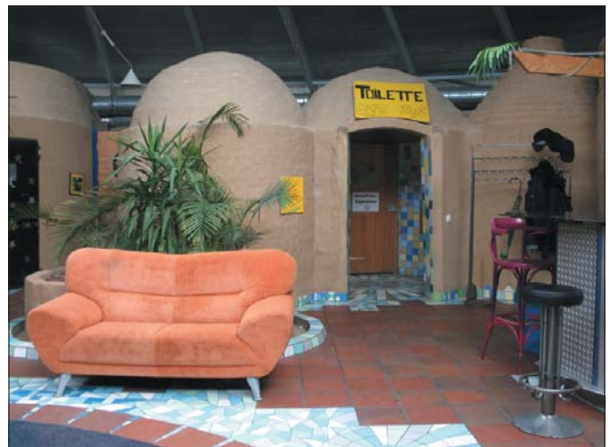
Für freie Formen eignet sich Lehm ganz besonders. Beim Jugendhaus Möglingen wurden die Lehmsteine vor Ort hergestellt, vermauert, ver- putzt und teilweise mit Skulpturen verziert.
