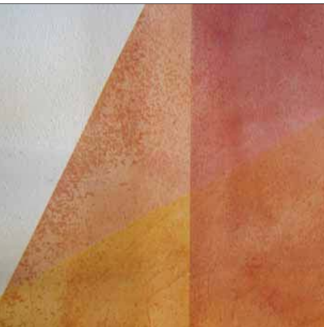
Verblüffende Effekte an der Wand: Farbintensive Silikatlasuren betonen das natürliche Rissbild des Kalk-Zementputzes und seine Körnigkeit.
